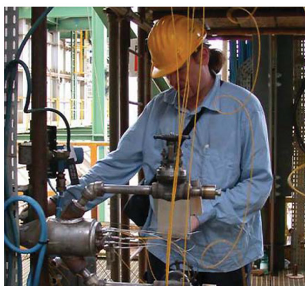
Tareas de mantenimiento en una cámara de seguridad
